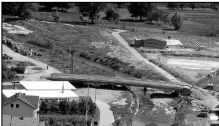
Новият мост и плувен басейн в Босилеград
